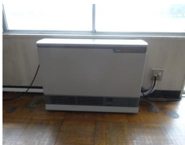
暖房機設置 72台
