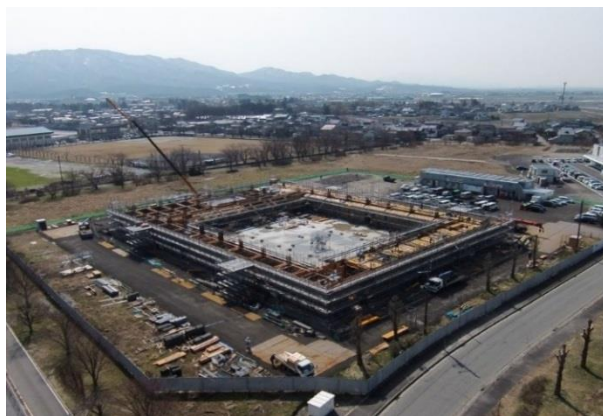
継続工事中の「総合体育館」
