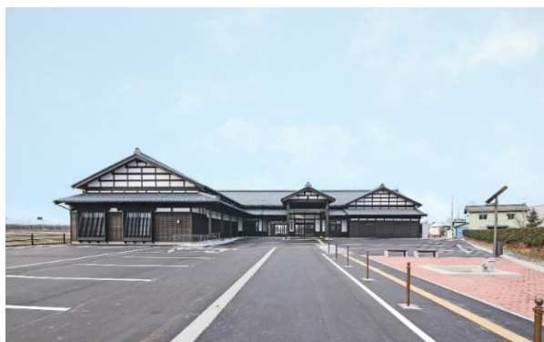
完成した、「 乙地区 交流施設」
