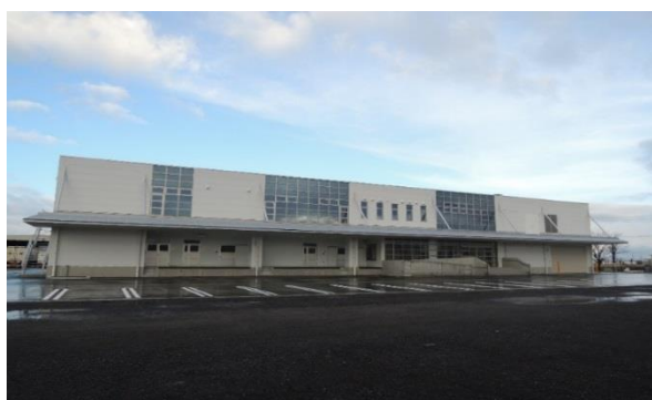
完成した、「 統合 学校給食センター」
