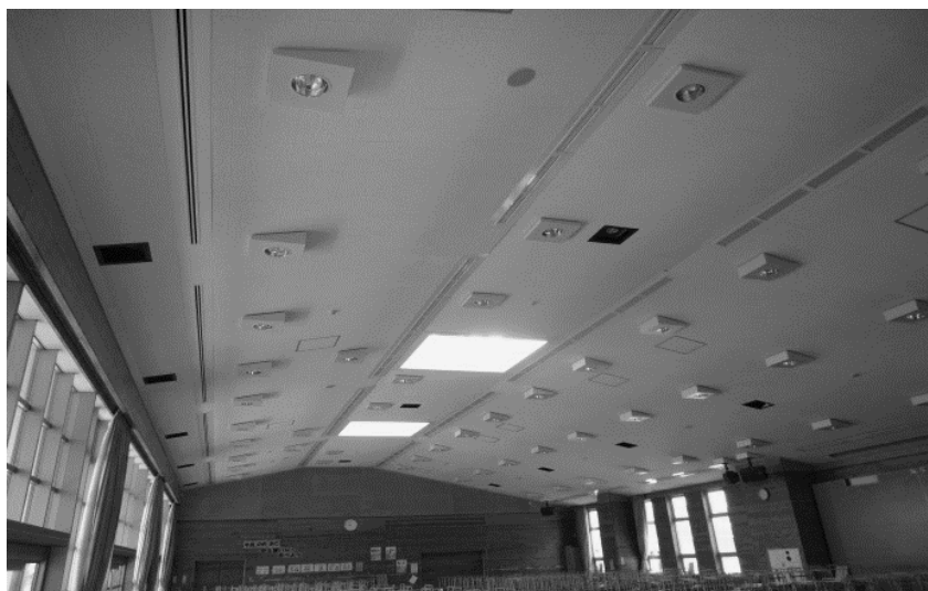
吊り天井を再設置し落下防止対策を終えた食堂棟
