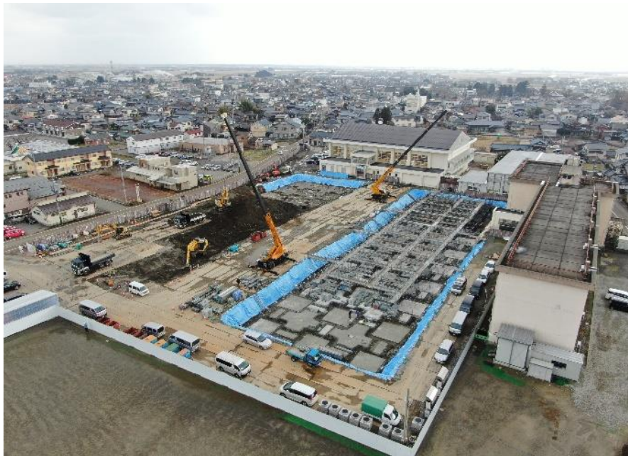
▲基礎工事 北東側全景
