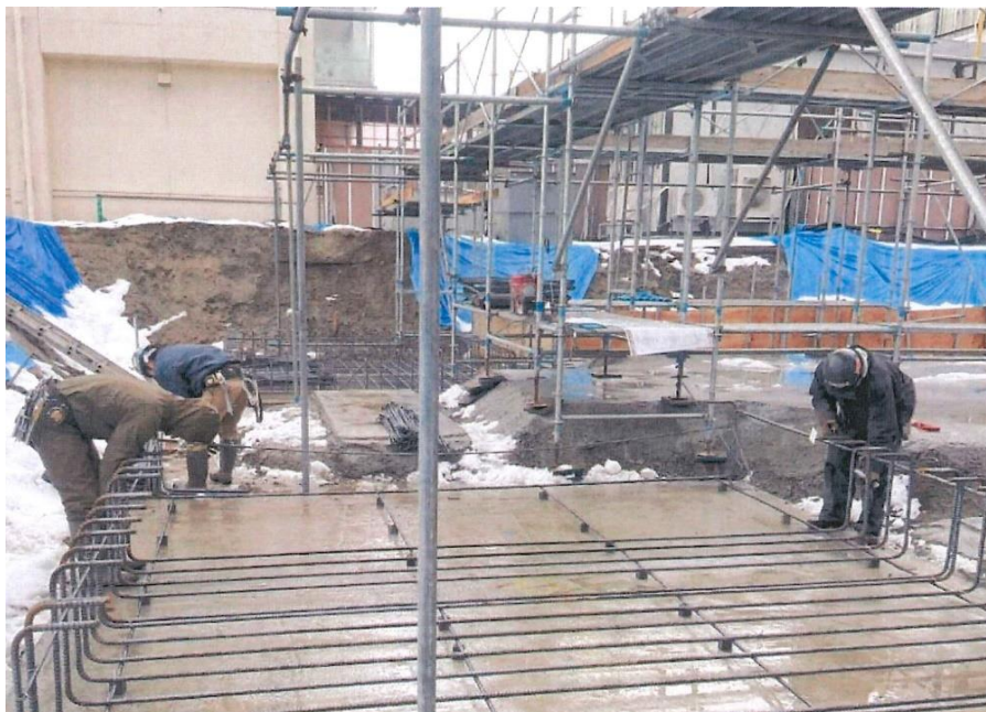
▲基礎工事 基礎配筋
