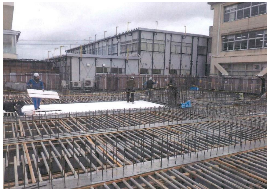
▲基礎工事 スラブ型枠兼用断熱材敷設
