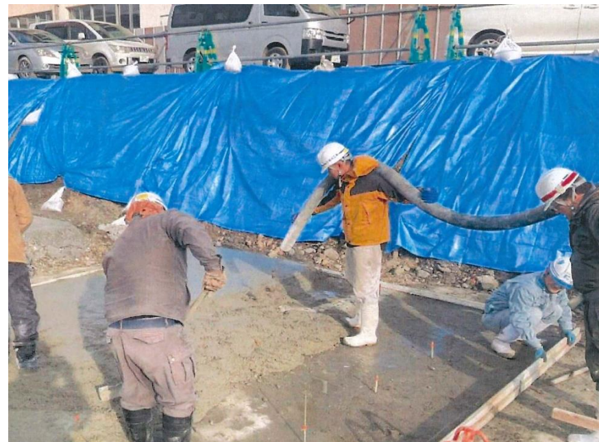
▲基礎工事 捨てコンクリート打設
