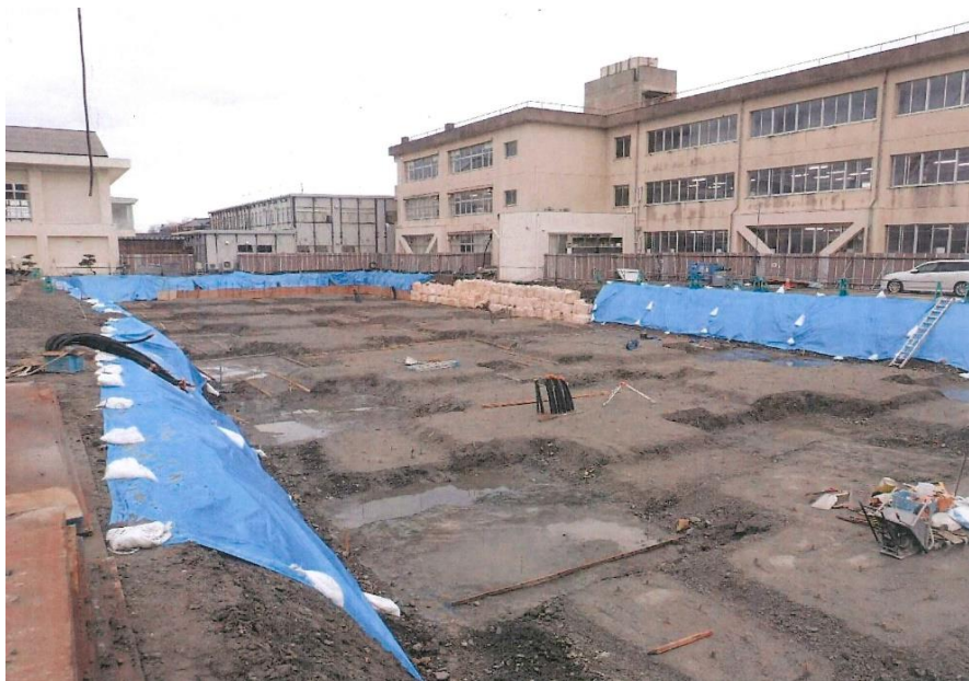
▲基礎工事 根切・砕石・捨てコン枠
