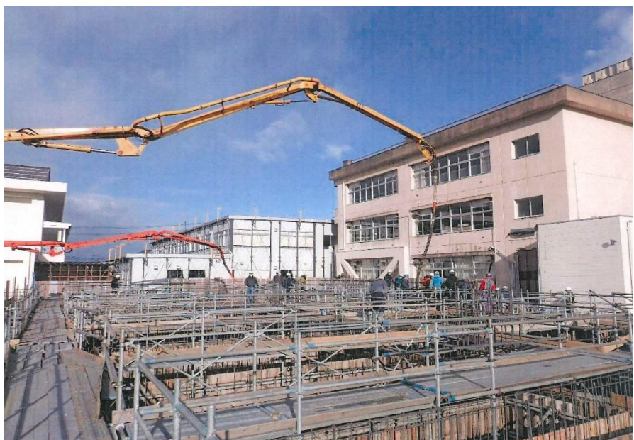
▲基礎工事 基礎コンクリート打設
