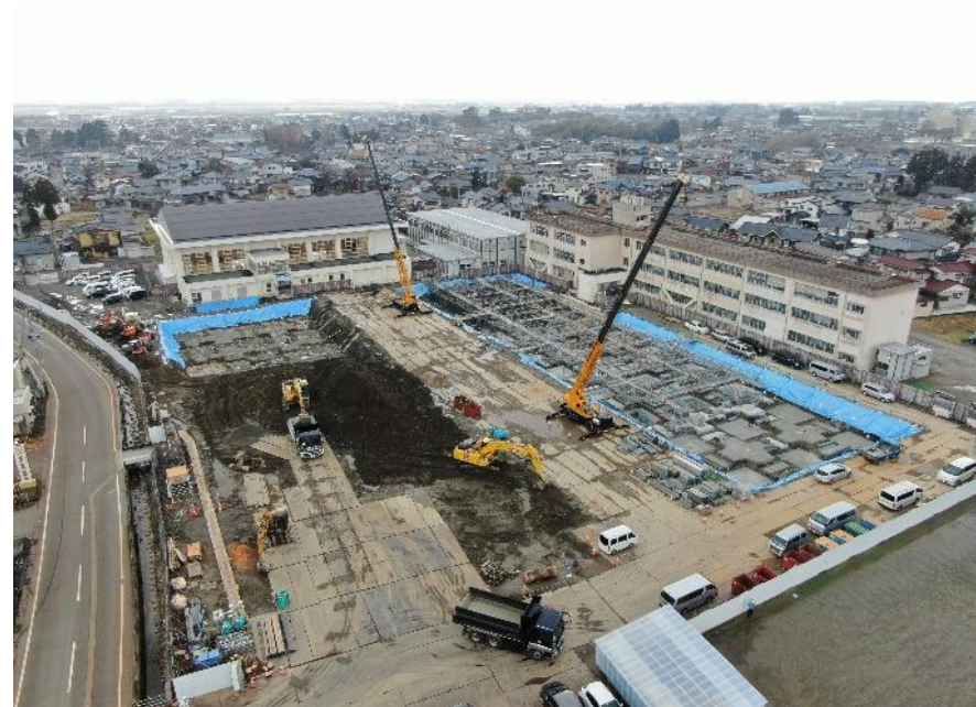
▲基礎工事 南東側全景
