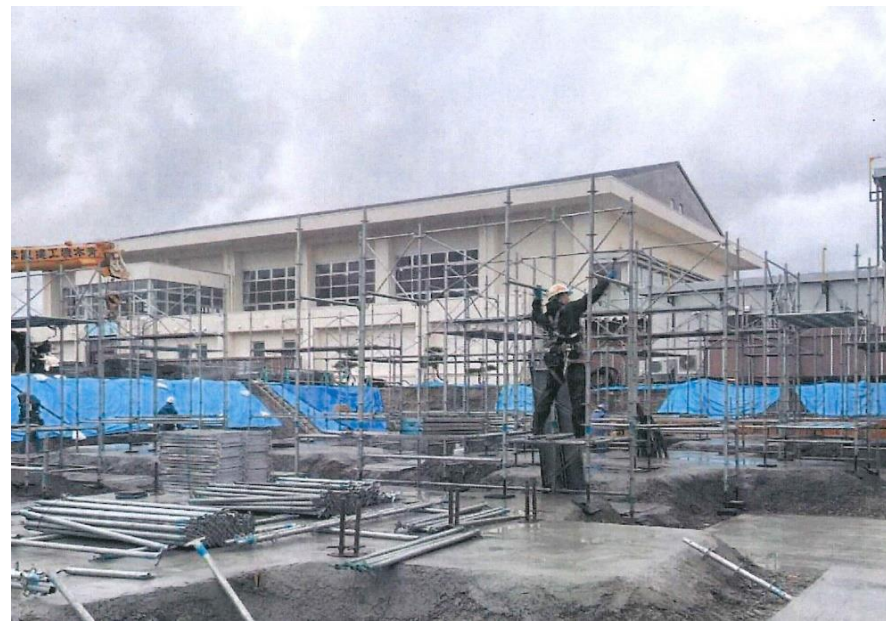
▲基礎工事 地足場組立
