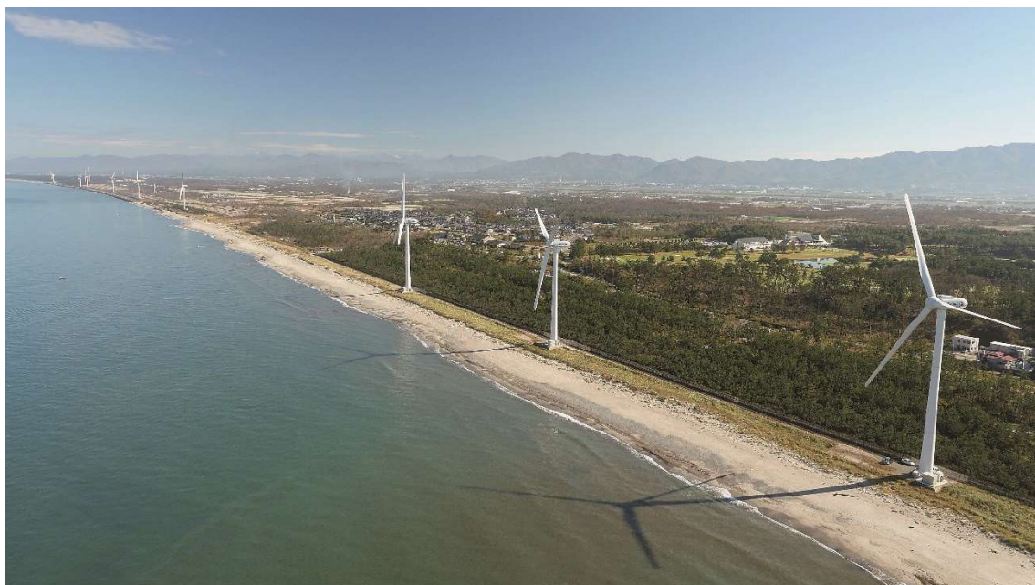
新潟県胎内市村松浜上空から撮影した陸上風力発電施設
