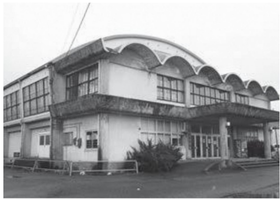
令和3年度に解体予定の黒川体育館
