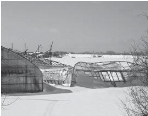
大雪で倒壊したビニールハウス
