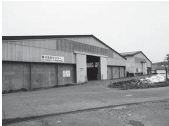
黒川堆肥センター
