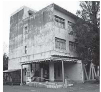
胎内市図書館(昭和33年建築)
