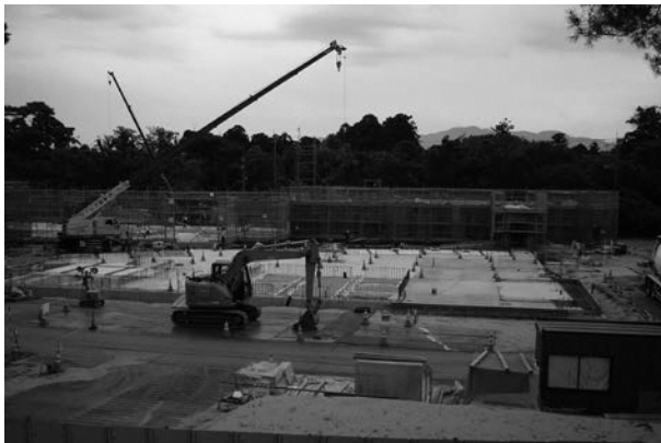
平成31年4月供用開始に向け建設中の新施設
