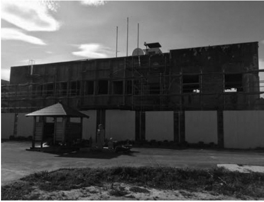
屋上付近まで水没した大槌町役場
