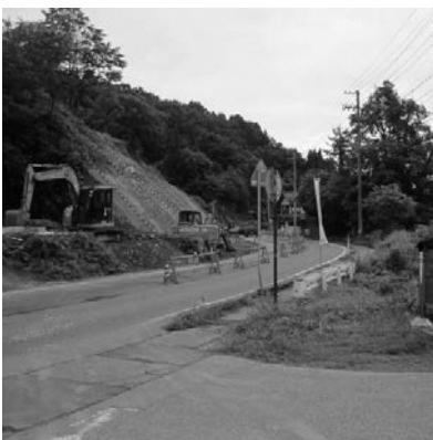
拡幅工事中の国道290号線
