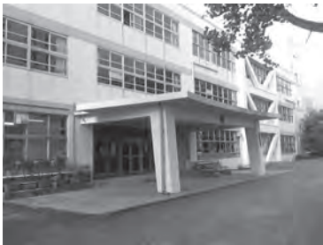
築後53年が経過した中条小学校
