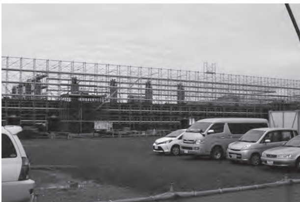
現在建設中の総合体育館・武道館
