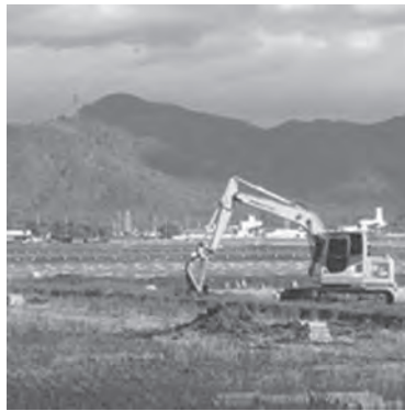
本条地区のほ場整備
