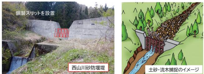
鋼製スリットにすることにより、通常時は水と土砂は下流に流れていきますが、大雨が降り土石流が発生したときは大きな岩、流木などを含む土砂は、堰堤に引っかかり止めることができます。
