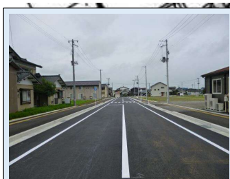
中条駅西口通り線整備事業
