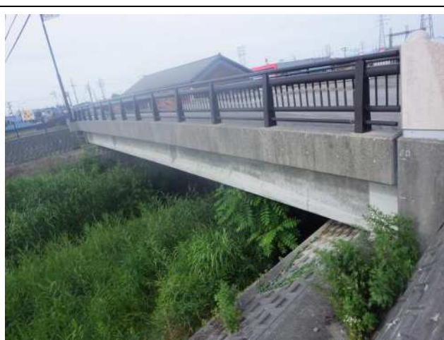
写真全景（コンクリート橋）
