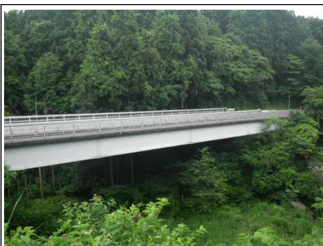
写真全景（鋼橋）
