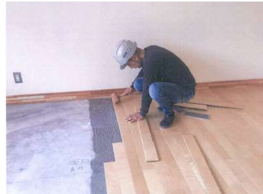
▲北校舎棟 床フローリング貼り
