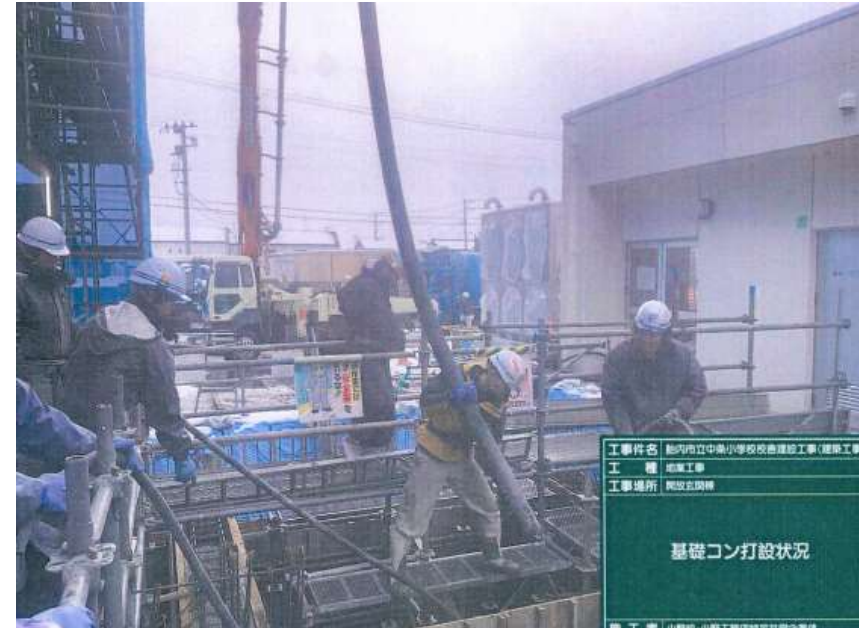
▲開放玄関 基礎コンクリート打設
