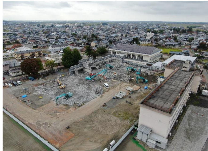
▲解体中 北東側全景
