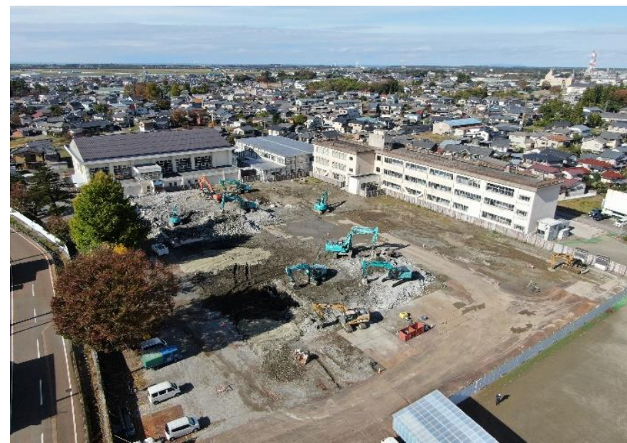
▲解体中 北東側全景
