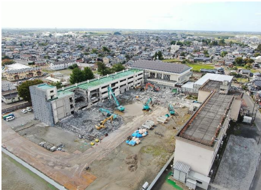
▲解体中 北東側全景
