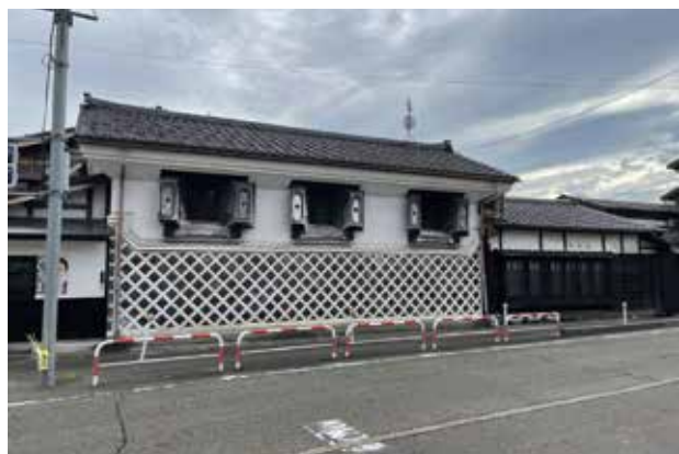
写真 9-12 荒惣店舗兼主屋・見世蔵・内蔵
