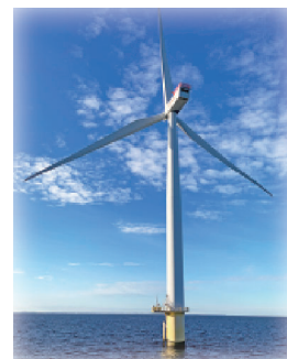
撮影：日本風力発電協会
