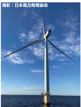
撮影：日本風力発電協会
