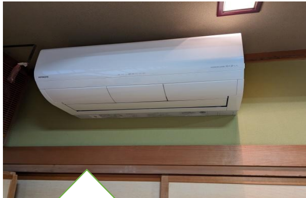
エアコン設置 (3台)
