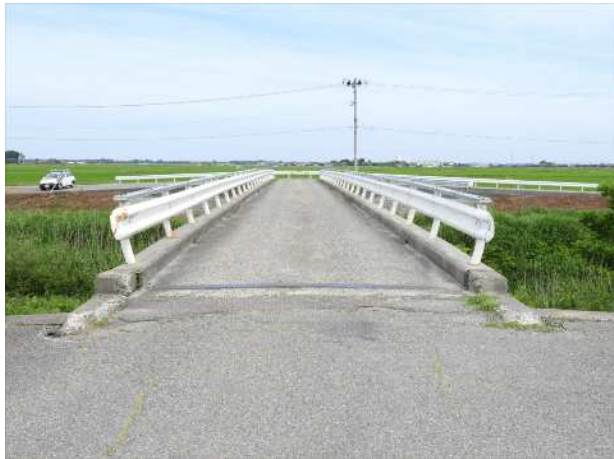
現地写真 近景(路面のわかる写真)
