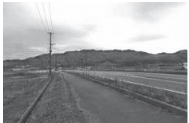
連絡管接続箇所
