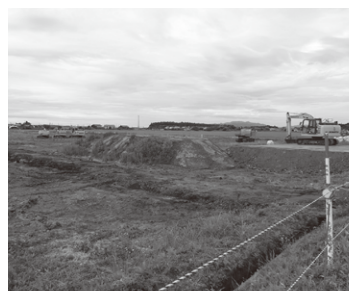
ほ場整備(平木田柳原地内)
