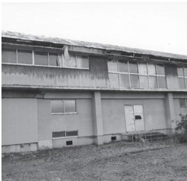
老朽化が進行し、解体が検討される旧村松浜小学校
