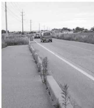
歩道の延長が望まれる県道54号線
