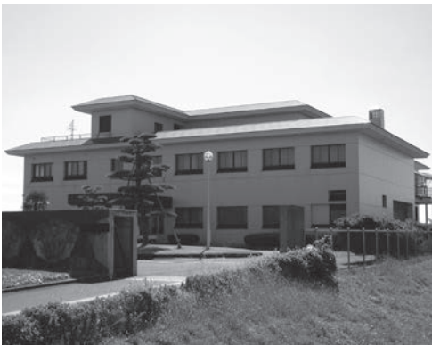
中条浄化センター
