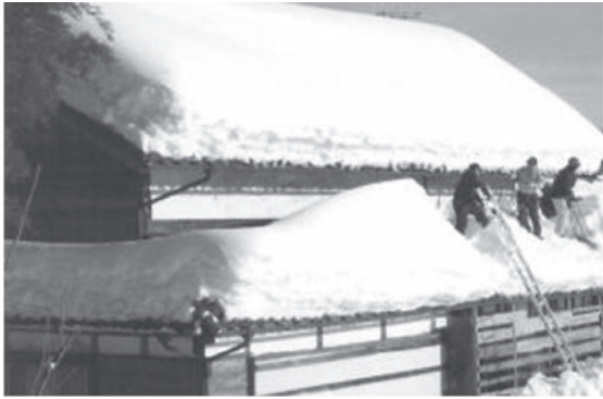
屋根の雪下ろし
