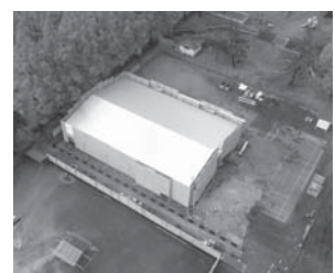
樽ヶ橋遊園休憩所『たるる』(建設中)
