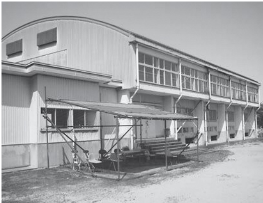
旧地域スポーツ施設乙屋内運動場
