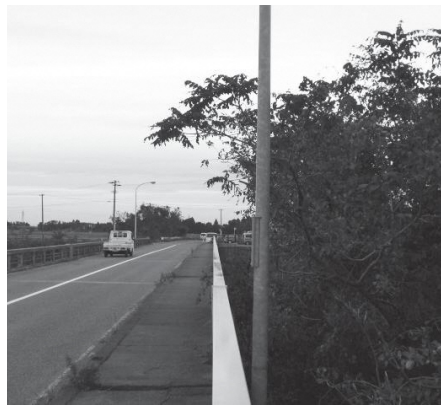
雑木が大きく茂っている黒川橋
