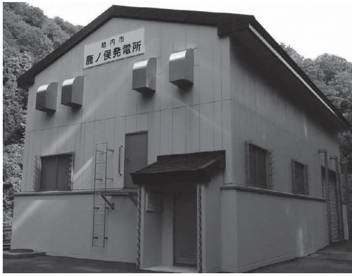
鹿ノ俣発電所
