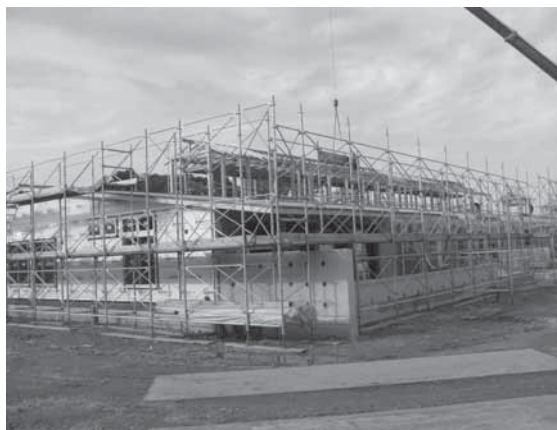
中条すこやかこども園建設現場
