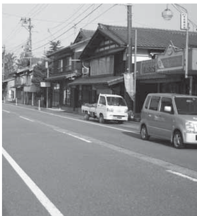
黒川地内消雪パイプ
